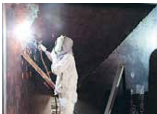
大型ダクト製作
