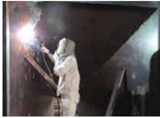
大型ダクト製作
