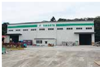
リサイクルセンター建屋
