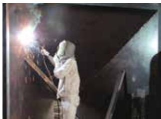
大型ダクト製作
